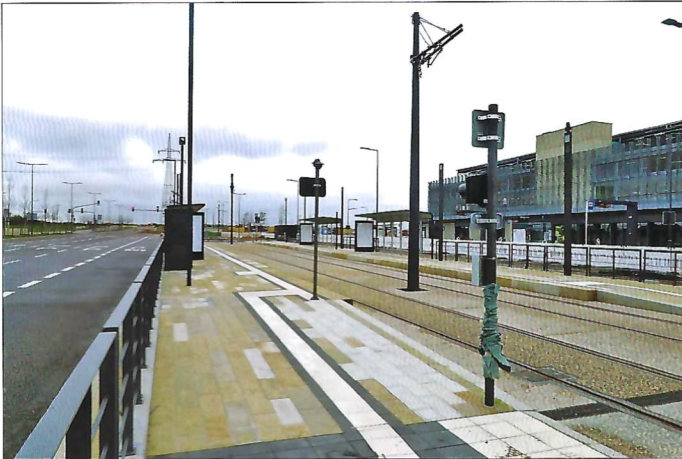
Der Endhaltepunkt Stade de Luxembourg wird am 7. Juli 2024 von der Tram in Luxemburg erreicht werden. Rechts das neue Parkhaus und der Busbahnhof. Bis auf die Oberleitung waren Anfang Januar dieses Jahres die größten Arbeiten hier abgeschlossen. Sämtliche Aufnahmen: R. Birgen
